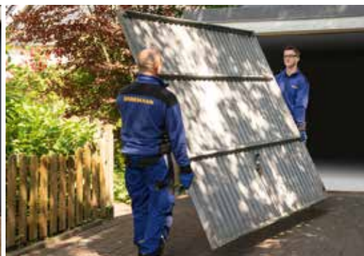
Ausbau und umweltgerechte Entsorgung
